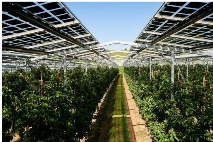
Abbildung 7 - Hoch aufgeständerte Agri-PV-Anlagen (Fraunhofer ISE)
